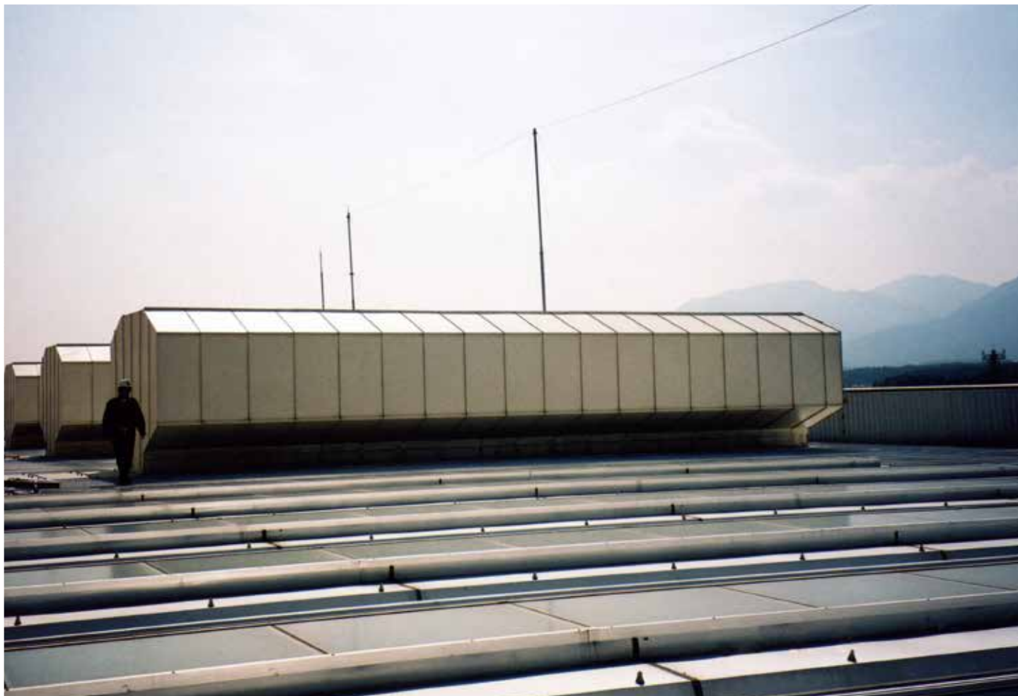
自然換気ベンチレーター（トップライト内蔵型）及び 折版トップライト
